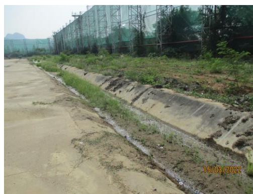
รูปที่ 20 ระบบรวบรวมน้ำบริเวณลานกองกากอ้อย
