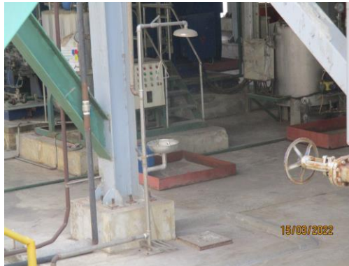
รูปที่ 47 ฝักบัวและอ่างล้างตาฉุกเฉิน
