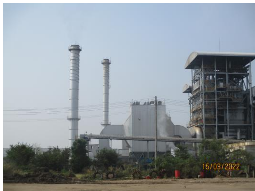
รูปที่ 1 ระบบดักฝุ่น Electrostatic Precipitator (ESP)
