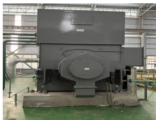
รูปที่ 46 ฐานวางเครื่องกำเนิดไฟฟ้า
