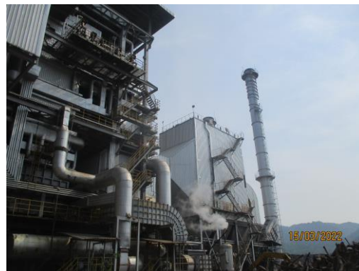
รูปที่ 1 ระบบดักฝุ่น Electrostatic Precipitator (ESP)
